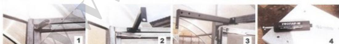
4. Просверлить отверстие Ø 4-5 мм, либо установить на верхний профиль двери уголок для крепления пружины на расстоянии 190-200 мм от оси вращения
